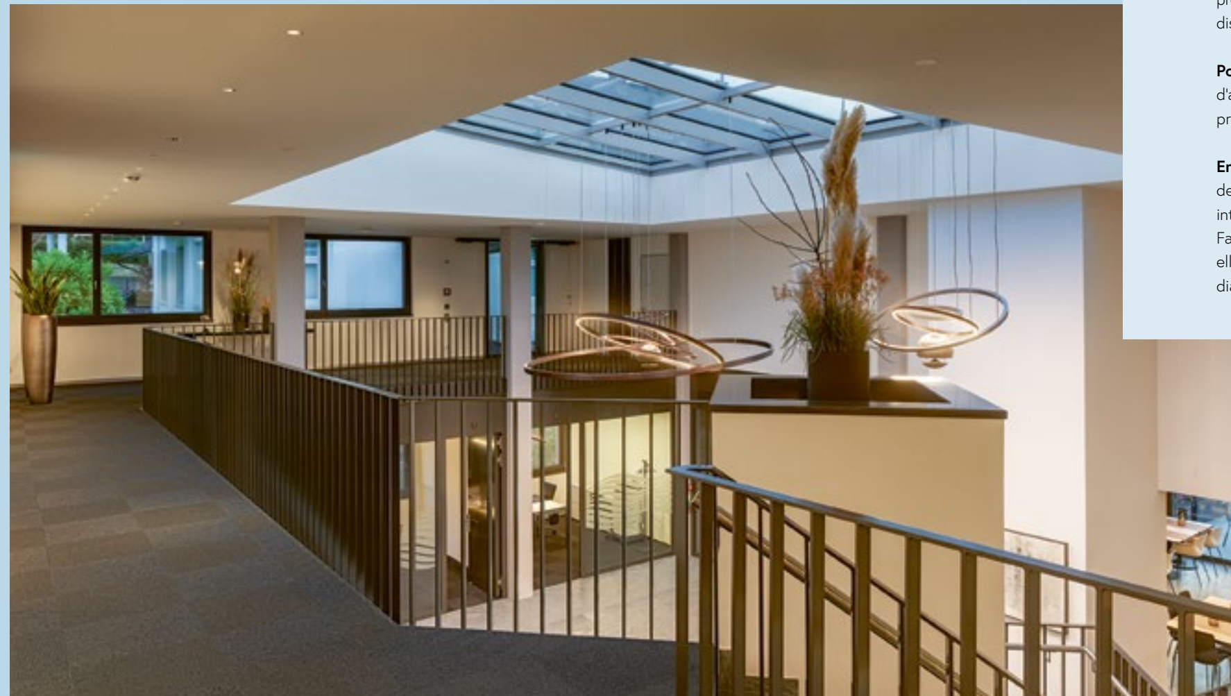
Fabrication spéciale pour la clinique Seeschau: les deux suspensions en anneau sont le point de mire du grand hall d'accueil. Les murs de l'étage supérieur sont également éclairés par des lèche-mur à lentille TriTec.
